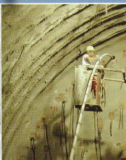
Infilaggio del VTR nella roccia perforata dal posizionatore.
